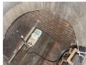
Flo-Dar- Installation im Kanal
