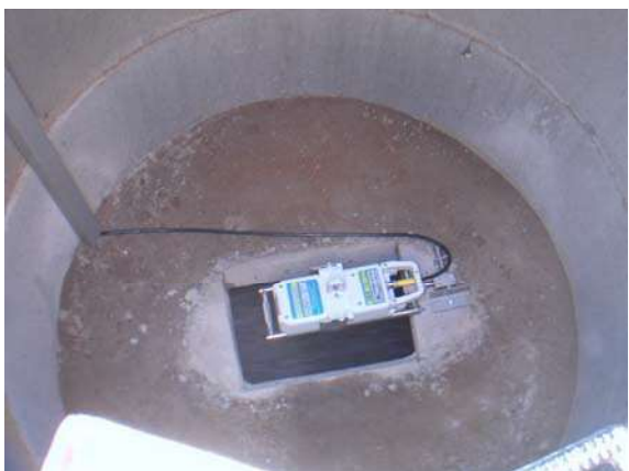
Sensorinstallation über geschlossener Rohrleitung. Fließgeschwindigkeit ( > 3 \text{ m/s} ) im Talsperrenauslauf
