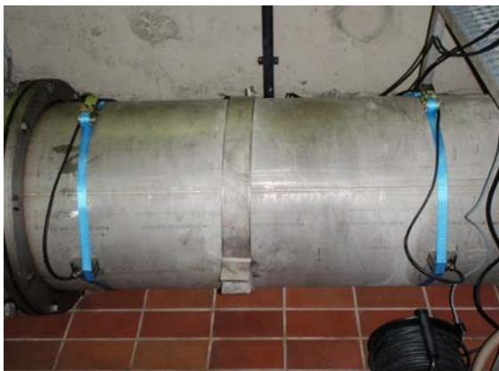
Druckrohrmessung mit Clamp-On
